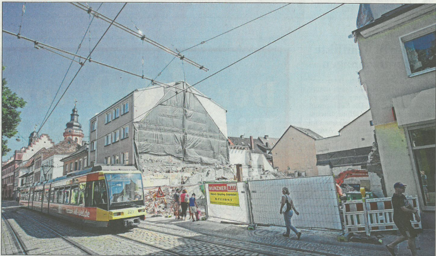
ABRISS: An der Pfnztastraße klafft bei der Friedrichschule ein Loch. Das Modehaus Nagel hatte dort seine Schaufenster, es ist in die Nähe der Stadtkirche (hinten) umgezogen. Auch ein kleines Nachbarhaus ist weg. In der Lücke baut die Volksbank. Foto: jodo
