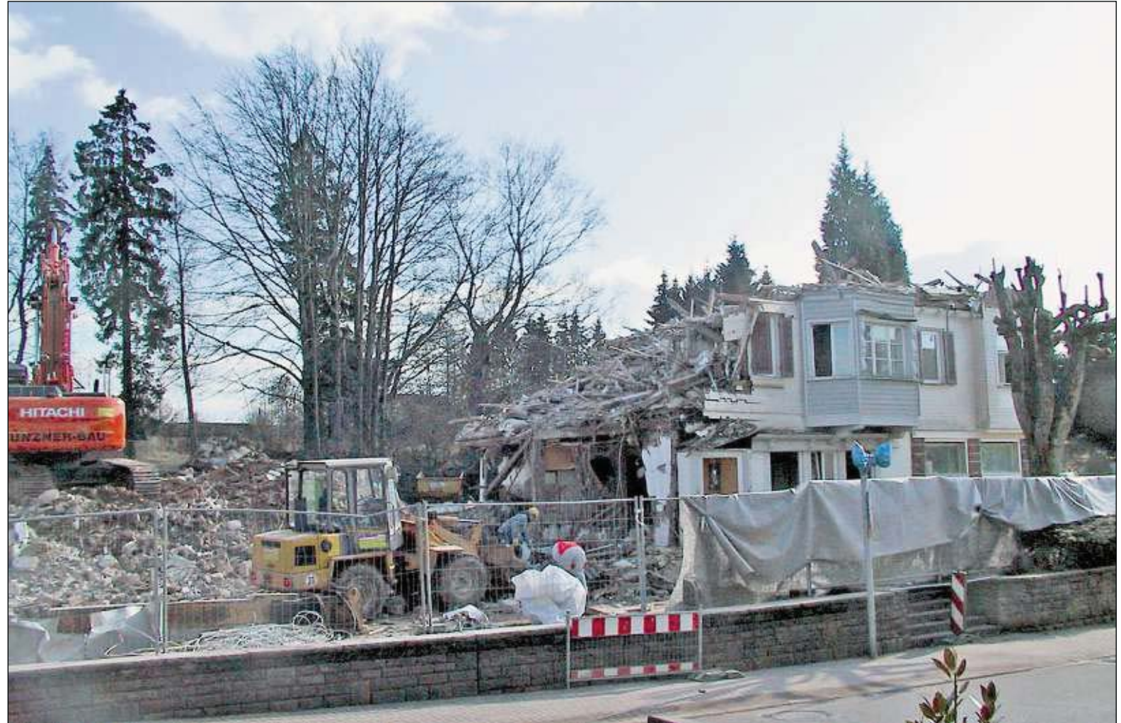
VIEL GELD gibt die Gemeinde Dobel für den Abriss des einstigen Luxushotels „Funk“ aus. Das 6 500 große Areal möchte die Gemeinde Dobel nach dem Abriss vermarkten. Foto: bgr
