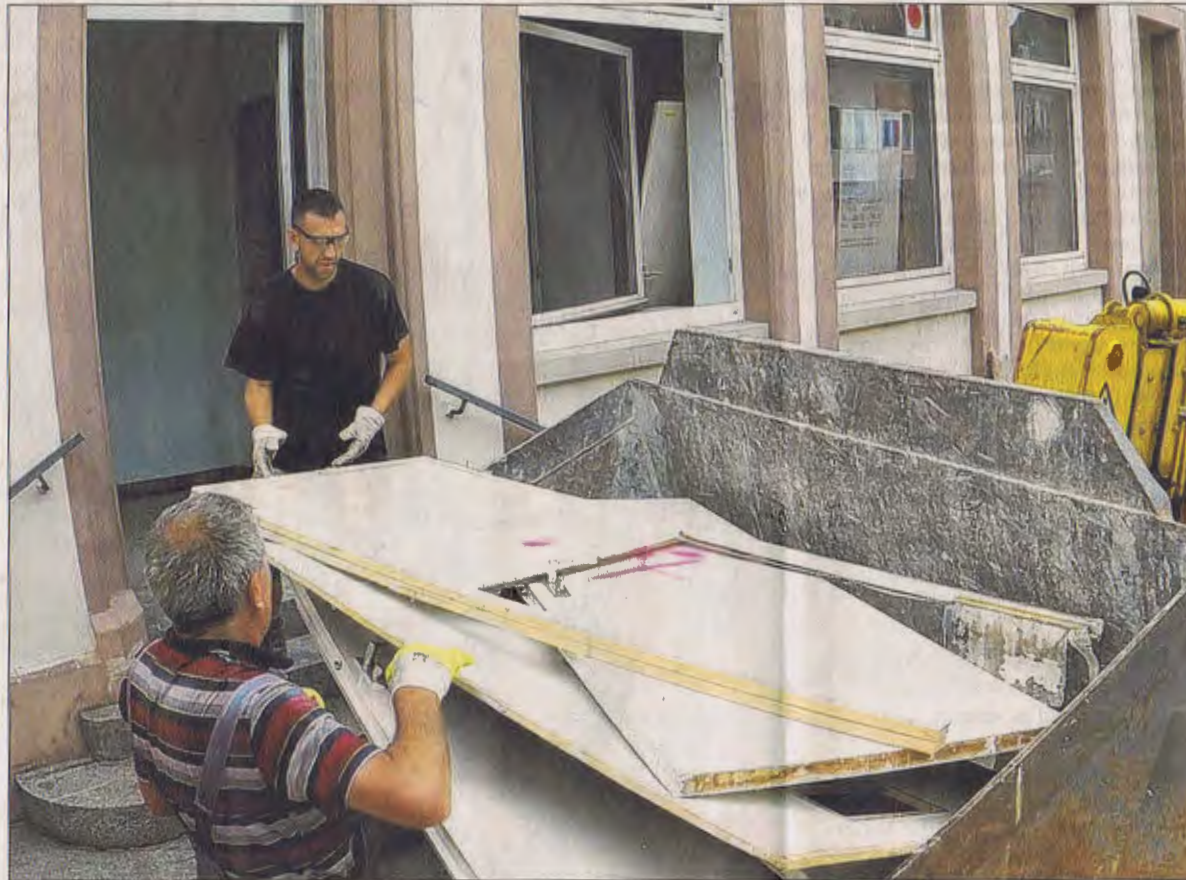
Alles muss raus: Deckenverkleidungen wie Zwischenwände wandern in die Schutt-Container.
