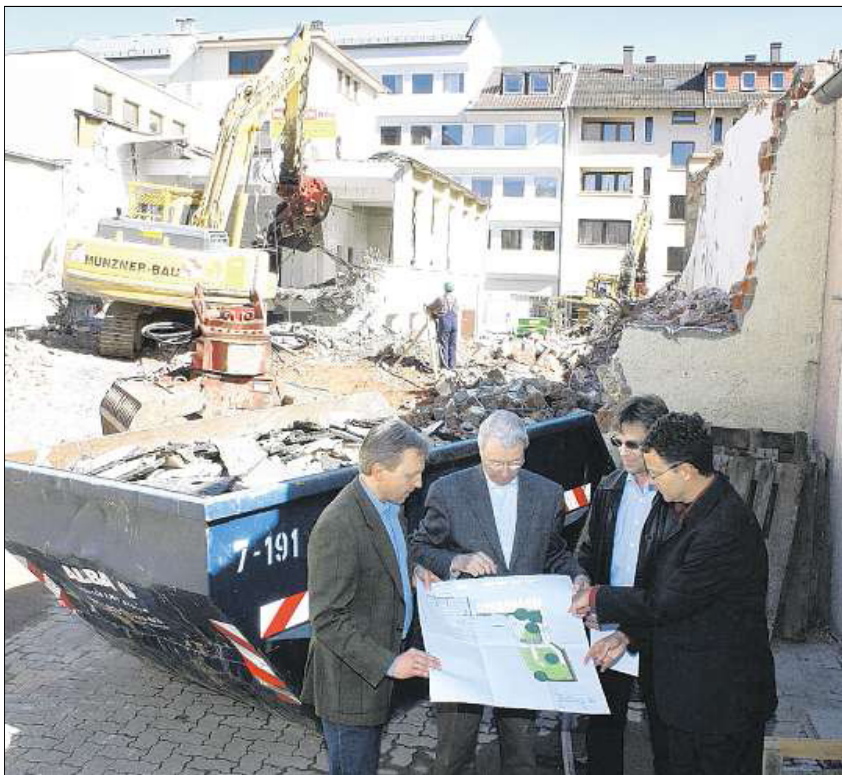
DER BAGGER FRISST sich durch die Mauern der früheren Firma Weber Druck in der Turnstraße. Im Vordergrund Bürgermeister Alexander Uhlig, Verwalter Kurt Schabenberger sowie die Stadtplaner Martin Eisenhauer und Reinhard Maier (von links). Foto: Wacker
