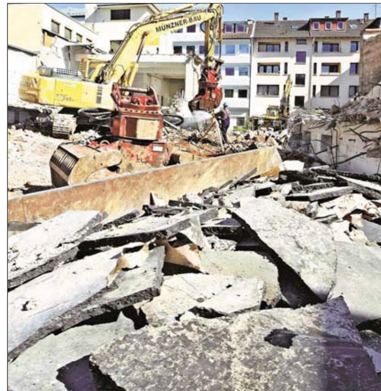
Der Bagger räumt die Trümmer einer alten Druckerei zusammen. Im Innenhof Turnstraße 1 soll ein Park entstehen. Foto: Seibel
