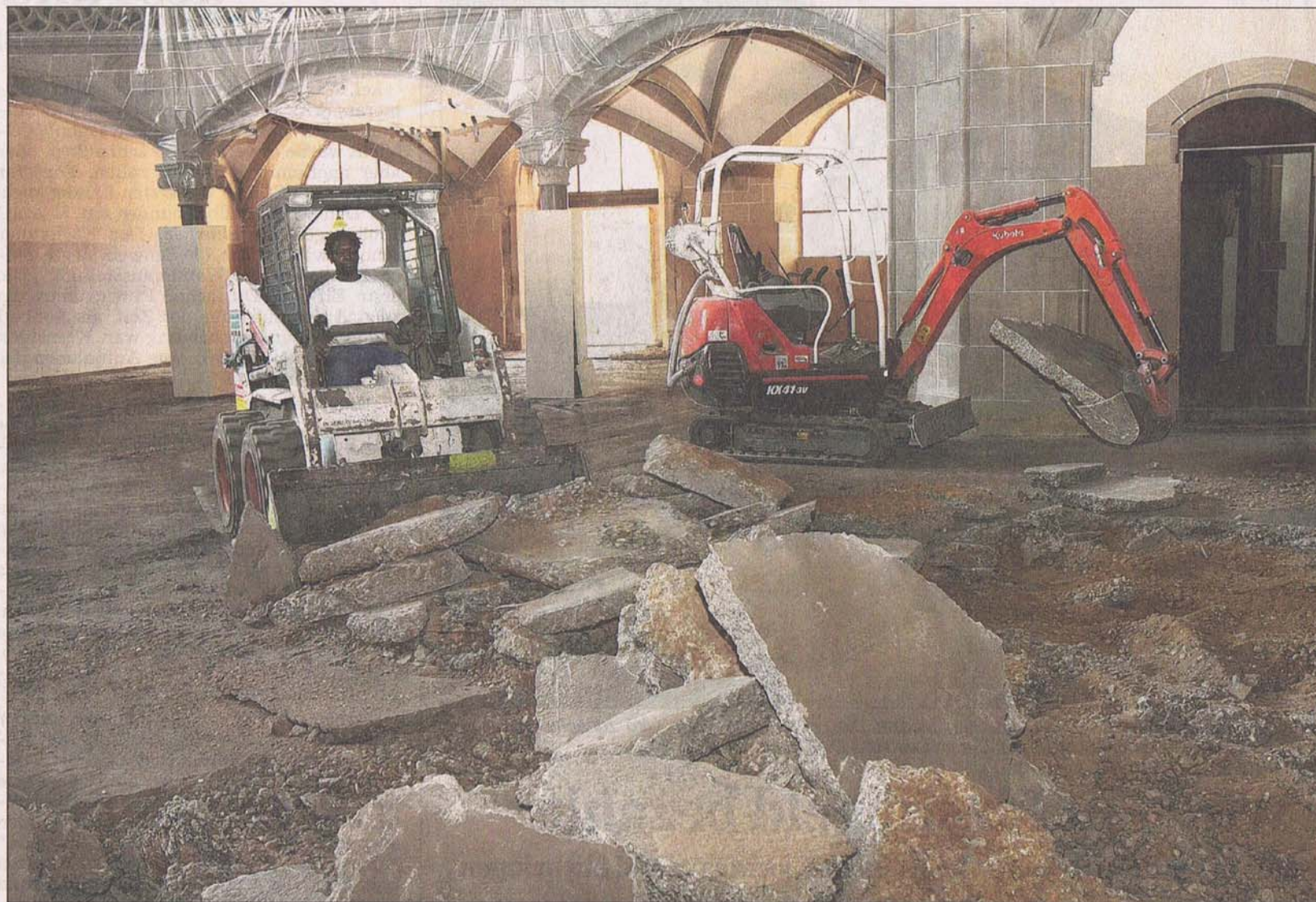
MINIBAGGER IN DER KIRCHE: Nur diese kleinen Baugeräte passen durch die Kirchentür. Innen entfernen sie die Bodenplatte. Später werden eine Dämmung und eine Fußbodenheizung eingebaut. Energiesparen ist auch in der Kirche ein Thema. Foto: jodo
