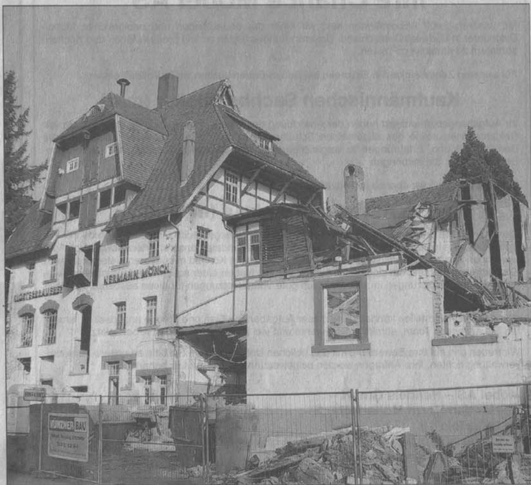
ENDE EINER HISTORISCHEN BRAUEREI: In der kommenden Woche werden die Bagger das altehrwürdige Haus abreißen. Foto: bgr
