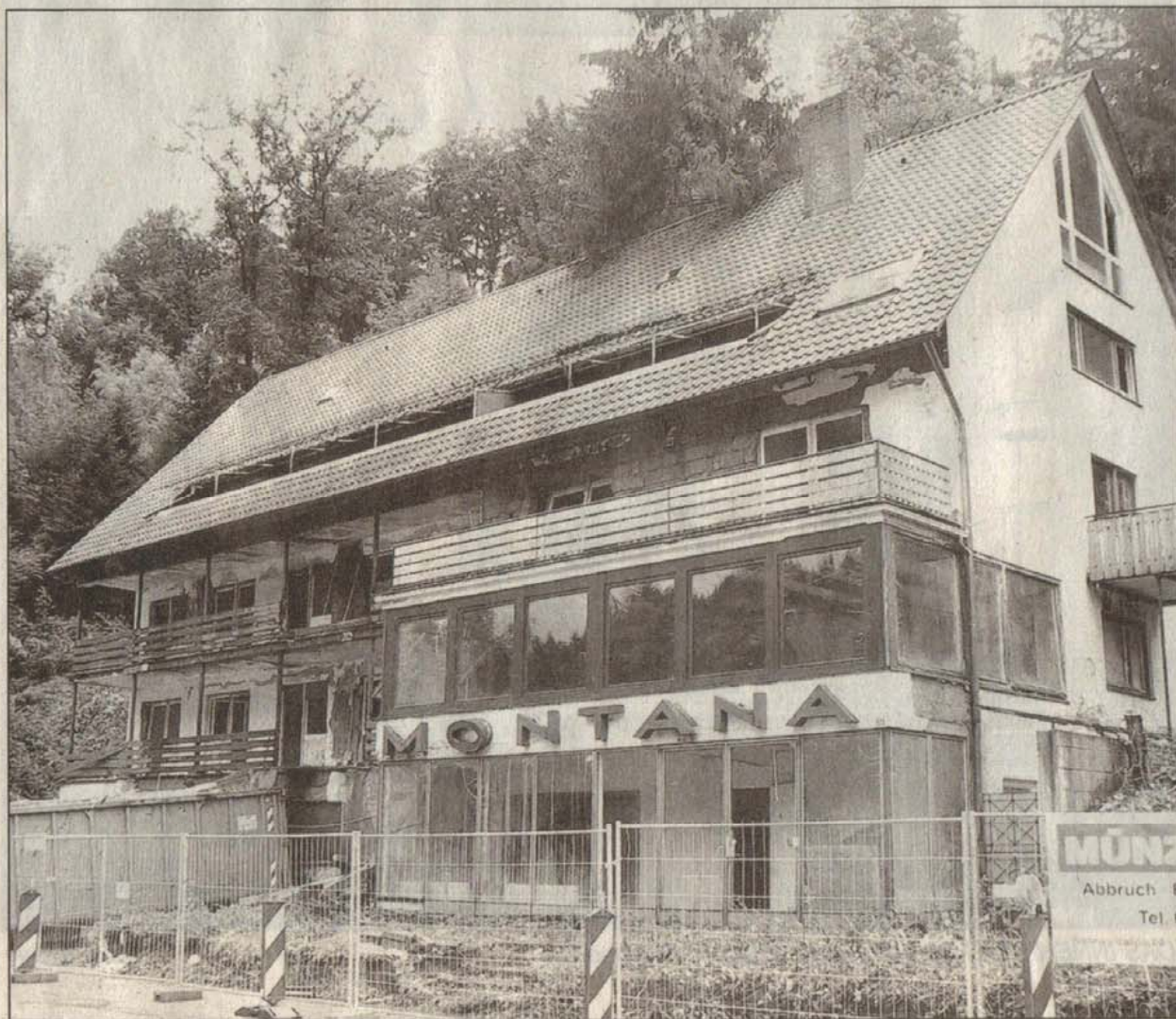
VOR DEM ABRISS steht das Hotel Montana in Bad Herrenalb. Das in den 50er Jahren erbaute 30-Betten-Haus steht seit Jahren leer. Foto: bgr
