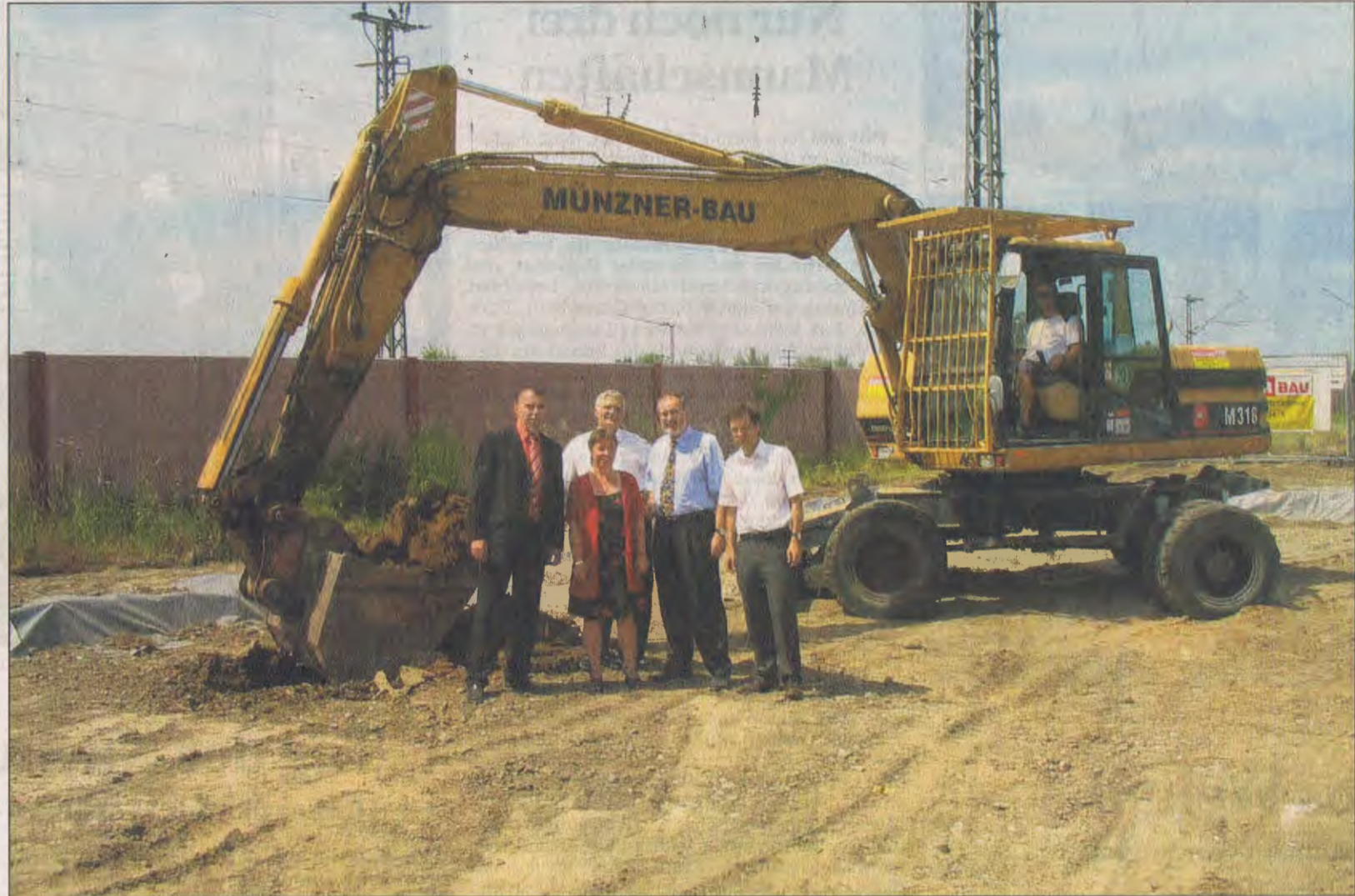
BAGGERBISS STATT SPATENSTICH: Bauleiter Gerd Waldenmaier (im Bagger) gab gestern Nachmittag mit Hilfe der schweren Baumaschine den Startschuss für den Neubau der Sozialstation Stutensee-Weingarten. Dabei assistierten ihm (von links) Claus Günther, Bürgermeisterstellvertreter aus Weingarten, Vorstandsvorsitzender Bernd Heß aus Weingarten, OB Klaus Demal, Architekt Henning Baumann und Geschäftsführerin Margit Seigfried (vorn). Foto: stst
