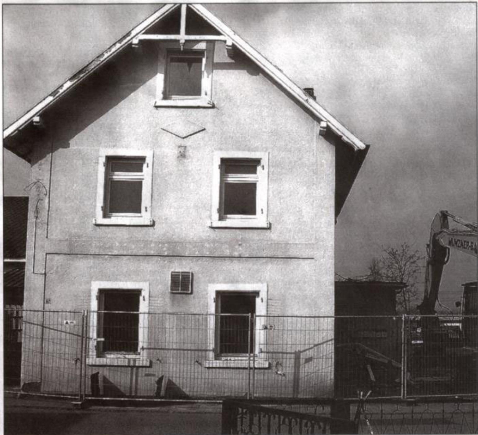
DIE EHEMALIGE FORCHHEIMER „KRONE“ in der Adlerstraße muss neuen Wohnhäusern weichen. Derzeit rückt der Bagger dem mehr als 250 Jahre alten Gebäude zu Leibe. Mit dem ehemaligen Gasthaus verschwindet auch ein traditionsreicher Saal in der Forchheimer Ortsmitte. Nach dem Abriss ist der Bau von sechs Reihenhäusern geplant.
