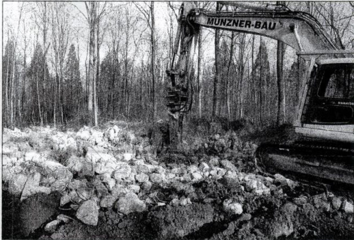
Drei Westwallbunker im Wald an der Baldenau werden derzeit plattgemacht.
