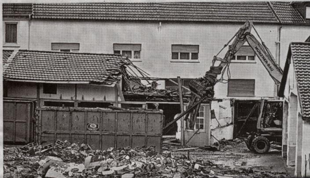
Das Ökonomiegebäude (siehe Schutt vorne) und der Schopf dahinter sind abgerissen.
