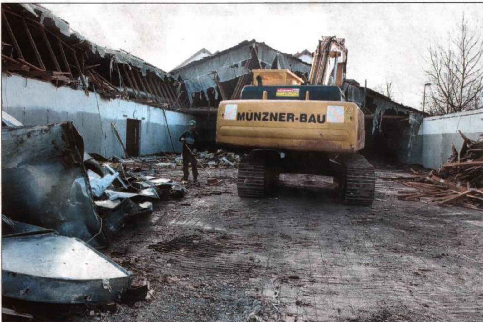
Gründlich abgeräumt: Binnen drei Tagen hatte der Bagger das Dach des einstigen Aldi-Marktes in der Lußheimer Straße abgetragen. Im Inneren waren die Einbauten zuvor weitgehend entfernt worden. Aldi-Kunden kaufen seit Sommer einige hundert Meter weiter ein. Bild: Lenhardt
