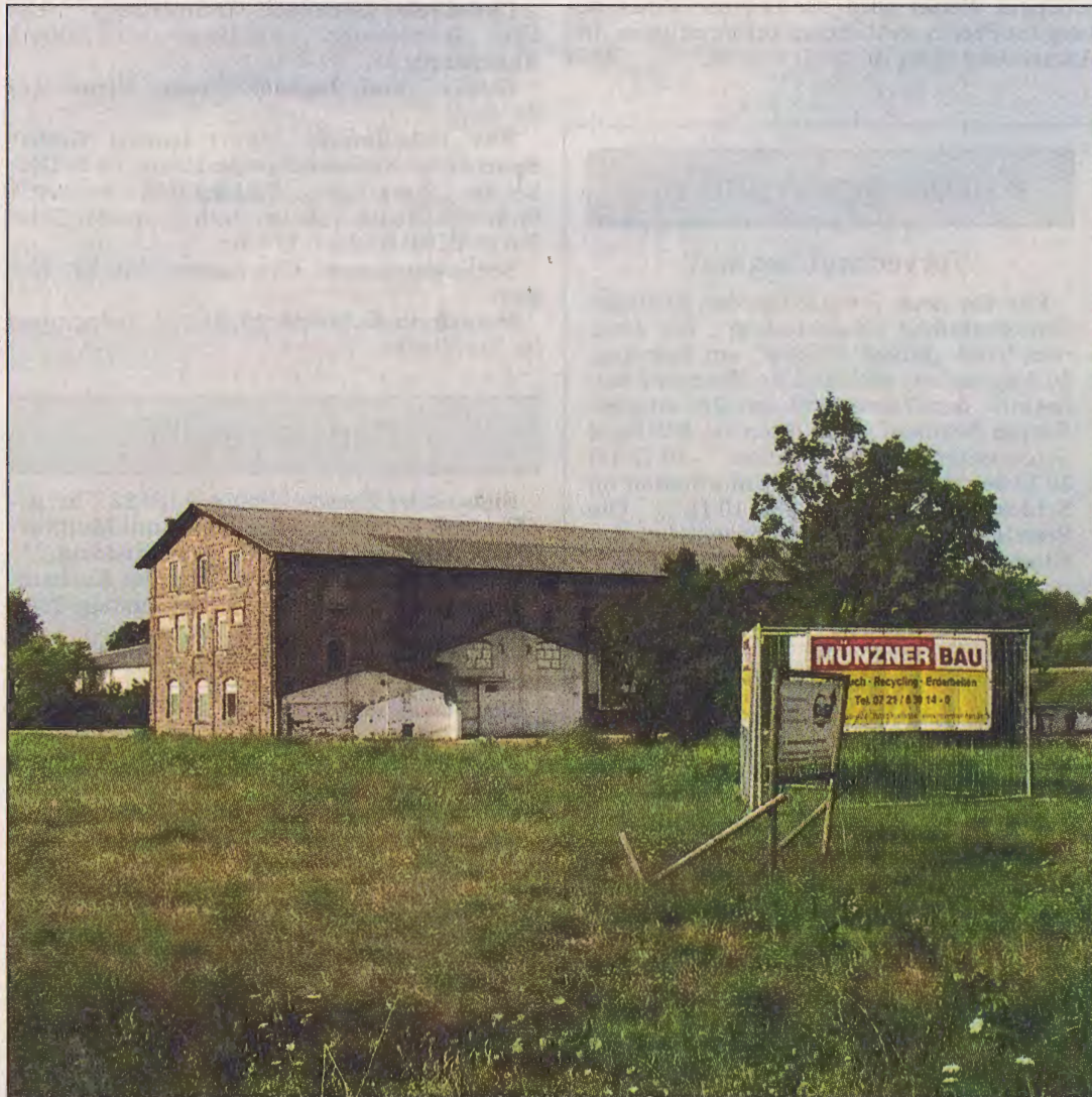
AM SEEHOF steht nur noch das rote Backsteingebäude, das die AVG vermietet hat. Andere baufällige Bauten wurden in den zurückliegenden Wochen abgebrochen. Foto: hei
