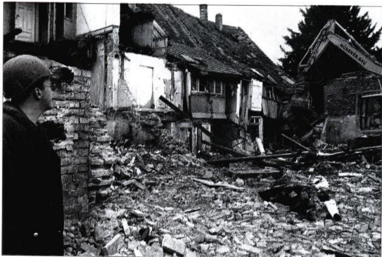
IN DER WERDERSTRASSE verschwindet jetzt ein weiteres Stück Alt-Rastatt. Von den drei alten Stadthäusern wird spätestens übermorgen nicht mehr viel übrig sein. Wann die Fläche einer Neubebauung zugeführt werden kann, ist derzeit noch nicht klar.
