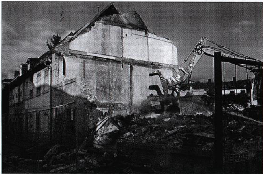
Ein Stück Alt-Rastatt verschwindet: Vier Häuser in der Werderstraße werden abgerissen. Foto: Melcher
