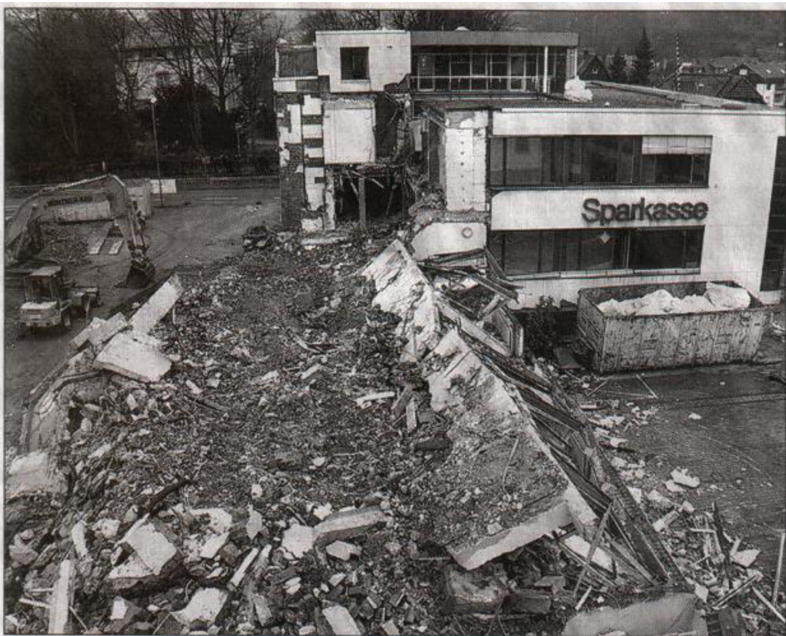
SCHON BALD VERGANGENHEIT ist das einst stattliche Gebäude der Gernsbacher Sparkasse. Das Haus wird derzeit abgerissen. Foto: Fieting
