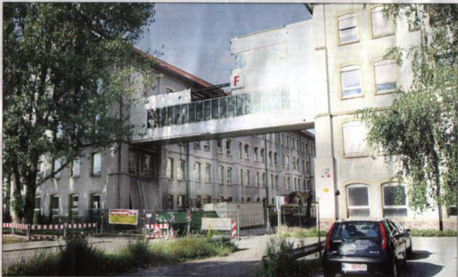
ENDE EINER ÄRA: Die Brücke über die Amalienbadstraße war ein Stück Wahrzeichen der im Jahre 1872 von Max C. Gritzner als „Nähmaschinenfabrik Gritzner“ gegründeten Firma. Jetzt wird sie abgerissen. Auf dem Firmengelände entsteht ein Gewerbepark. Foto: Donecker
