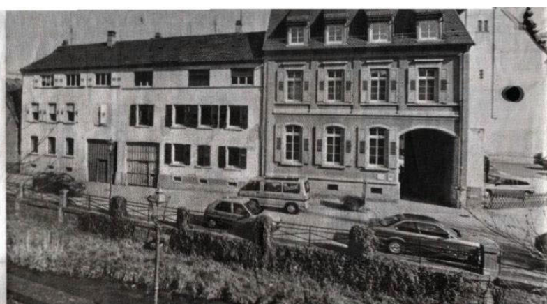
WO SICH HEUTE ENTLANG DER BAHNHOFSTRASSE noch eine geschlossene Häuserzeile darbietet (links), soll in zwei Jahren eine breite Öffnung zum Rathausplatz hinführen (rechts). Die Gebäude Bahnhofstraße 4 bis 10 werden in den nächsten Wochen abgerissen, nur die „Schrummel“, das Polizeigebäude, bleibt stehen. Das jetzt noch als Parkfläche genutzte „Lamm-Eck“ wird mit einem Winkelbau belegt, der sich jedoch dem Rathaus und der „Schrummel“ in der Höhe unterordnet.
